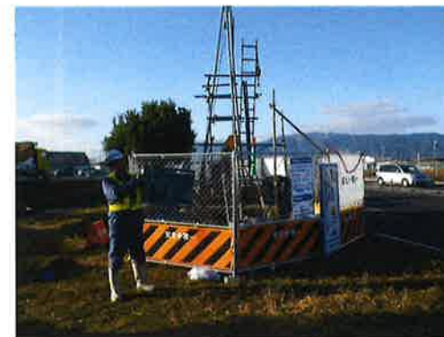
ボーリング作業例
