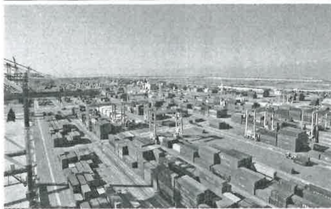
万博開催に向けた工事が本格化すれば、関西経済を支える物流との両立が求められる(写真は夢洲コンテナターミナル)
