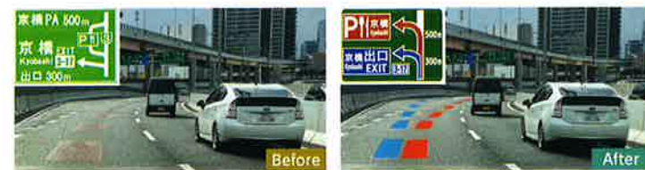
■京橋出口への誘導を促すカラー舗装 ■京橋PAへの誘導を促すカラー舗装
