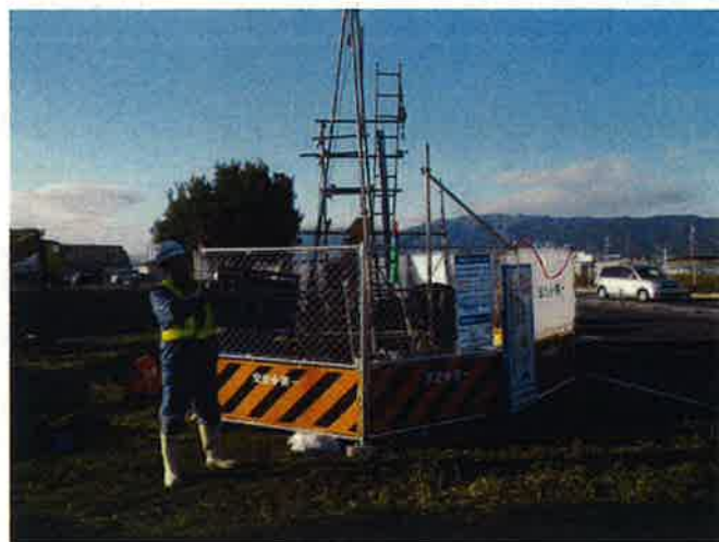
ボーリング作業例
