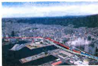
阪神高速 3号神戸線 湊川～京橋 間の空撮 画像提供：阪神高速道 路
