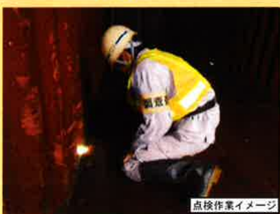
点検作業イメージ
