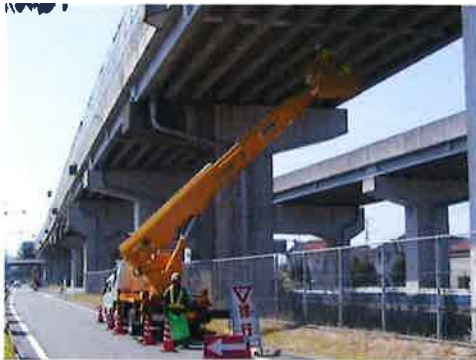
参考-1 高所作業車による点検 （新日本技研㈱HPより）
