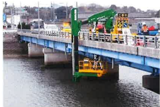
参考-2 橋梁点検車による点検 （西鉄シーイーコンサルタント㈱HPより）
