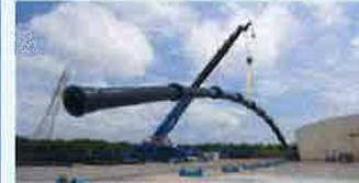
管と管との継手部分に隙間を設けて布設することで、地震時の地盤の動きに合わせて伸び縮みや曲がる機能を持たせています。
