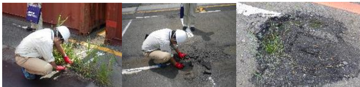
コンテナヤードでの確認
